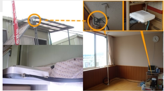
仮設消防本部に設置されたアクセスポイントと指向性アンテナ
