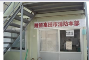
給食センターの隣に建てられた仮設消防本部
