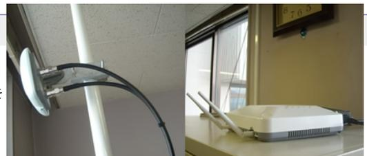
町役場側設置のアクセスポイントとアンテナ。アンテナはポール設置で簡単に取付・取外しが可能です
