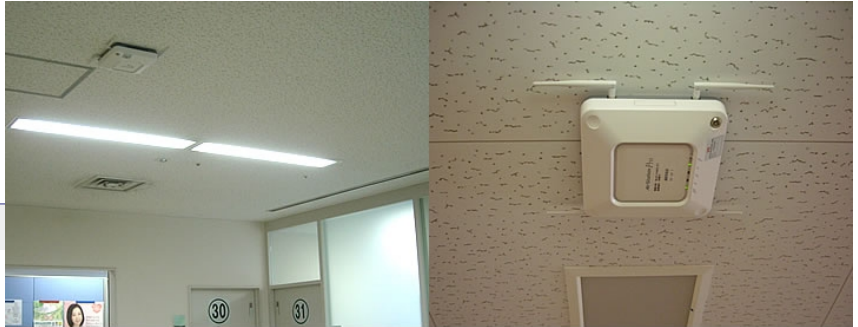
各階フロアの天井にアクセスポイントを合計40台を設置。工事もしやすいようスムーズに設置作業が行われました
