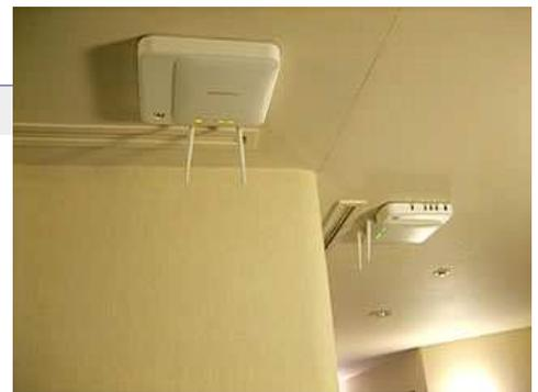
各階の客室フロアの天井にはWAPS-APG600Hが2~3台ずつ設置（この写真の対角にもう1台）され、設置されたフロア数は合計126フロアにのぼる。
