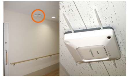
2階から5階には無線アクセスポイントを設置。新病院の建築中にAirStation Admin Toolsを使用、無線がつながる最適な配置を行うことができました。
