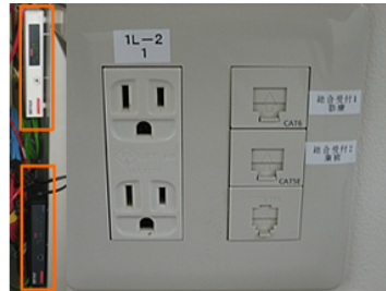
各階の末端フロアハブはLSW4-GT-BNSの2色のカラーモデルを診療用と業務用で分けて使用。情報コンセントもわかりやすく表示して使いやすく。
