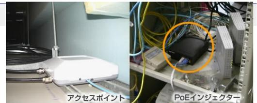
教育センター側のアクセスポイントは天井内に設置。ただし天井内に電源がないためにLANケーブルで給電できるPoEインジェクターも同時に導入しました
