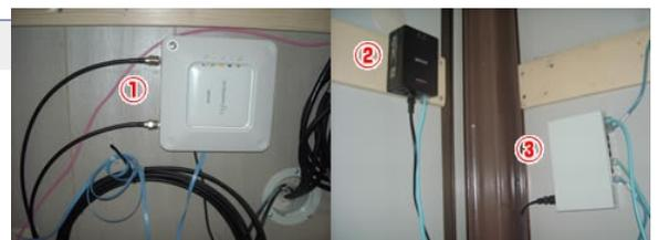
教育センターからの無線を①アクセスポイントWAPM-APG300Nが受け、そこから有線につながれた別のアクセスポイントが無線で他のプレハブに設置した②無線LANコンバーターWLAE-AG300N/VIに接続。プレハブ内のクライアントパソコンには③有線ハブで分配しています。
