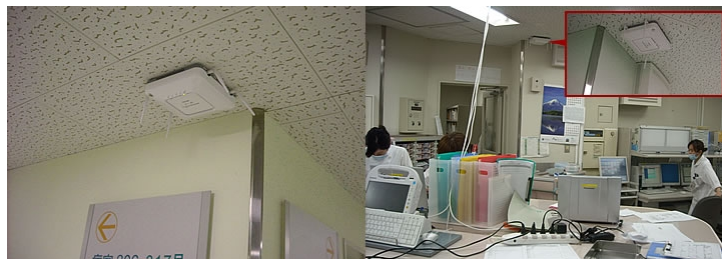
各病棟のフロア天井やナースステーションなどに無線LANアクセスポイントを設置
