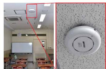
予備教室に設置した無線LANアクセスポイント。入念な導入設計により、安定稼働しています。
