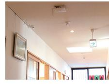
Wi-Fiエリアをカバーするため、各階の廊下天井に「WAPM-1266R」を計8台設置。
