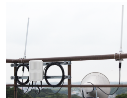
研究棟屋上に屋外用アンテナとともに「WAPM-1266WDPRA」を設置
