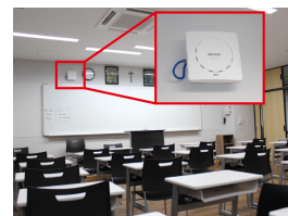
各教室に設置したWi-Fi 6(11ax)対応の「WAPM-AX8R」
