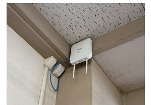
多台数同時接続対応、法人向け無線LANアクセスポイント「WAPM-1266R」
