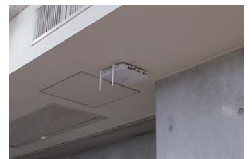
同時接続数が多い「WAPM-1266R」を採用することでスッキリした外観を実現
