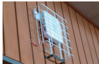
体育館には3台ほどの「WAPM-1266R」が設置されている。電波強度が高く、想定より半分の台数で済んだといいます。
