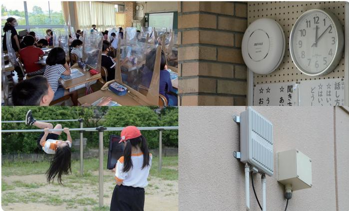
教室には多台数同時接続に強いトライバンドモデル「WAPM-2133TR」を採用。屋外への設置が可能な「WAPM-1266WDPRA」を運動場用として校舎壁面に設置。
