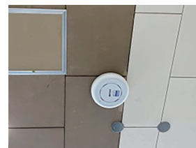
天井に設置された、法人向け無線LANアクセスポイント「WAPM-2133TR」。
