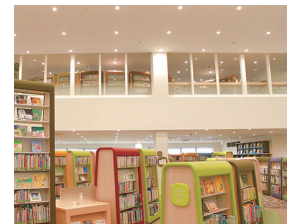
施設のデザインを損なわずに、無線LANアクセスポイントを極力目立たない場所に設置
