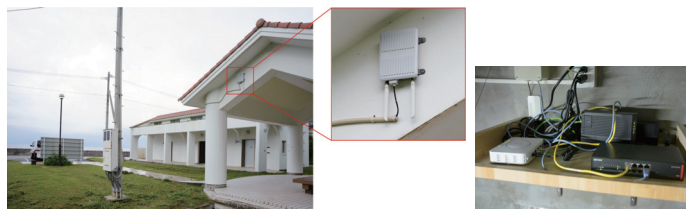
ワンジョ公園には、認証ゲートウェイ機器として「FS-M1266」を、屋外用無線LANアクセスポイントとして「WAPM-1266WDPR」を設置した。キャリア通信が届きにくいため、遊びに来た住民、観光客のスマートフォンを利用しづらかった問題を解決した。
