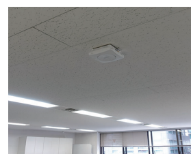
天井に設置された、「Wi-Fi 6(11ax)」対応無線LANアクセスポイント「WAPM-AX8R」。
