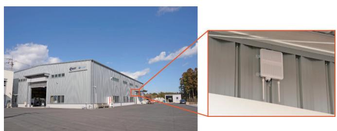
工場の外側の壁に「WAPM-1266WDPR」を設置し、加工室と駐車場をカバー。-25～+55℃まで対応の「WAPM-1266WDPR」なら、最低気温が-5℃を下回ることもある御殿場の冬にも耐えられる。
