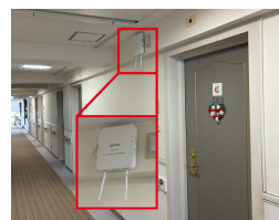
居室各フロアの天井や壁に設置された「WAPM-1266R」
