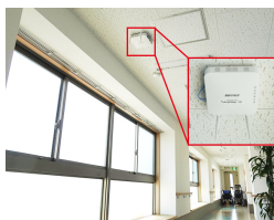
全施設で「WAPM-1266R」を採用し、廊下天井などに設置した
