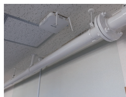
適度な間隔で「WAPM-1266R」を配置し、施設内全域に安定したWi-Fiを提供
