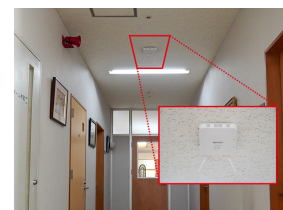
本館4フロア、リハビリ棟の2フロアに11台の「WAPM-1266R」を設置した
