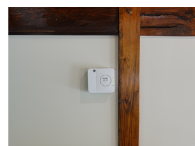
壁面に設置された、法人向け無線LANアクセスポイント「WAPS-1266」。
