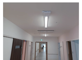
廊下の天井に約12m間隔で「WAPM-AX4R」を設置。
