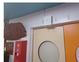
4台の「WAPM-AX4R」で3棟にわたる広範囲の通信をカバー
