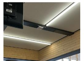
B1、1、2、3、7、9階の天井にWi-Fiアクセスポイント「WAPM-AX4R」を複数設置。
