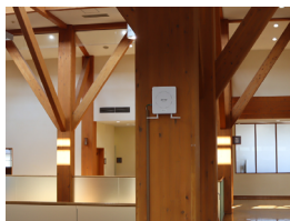
木造建築の魅力を損なわないよう、来庁者からは見えない柱の内側に設置。
