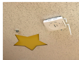
堅牢な作りの建物に対応するため、廊下だけでなく、各部屋にアクセスポイントを設置。
