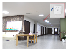
「WAPM-AX4R」を用いて施設内全域の通信をカバー
