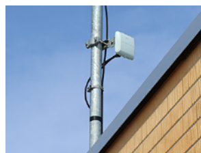
離れた拠点を無線で結ぶことで、雪による断線などの影響を回避
