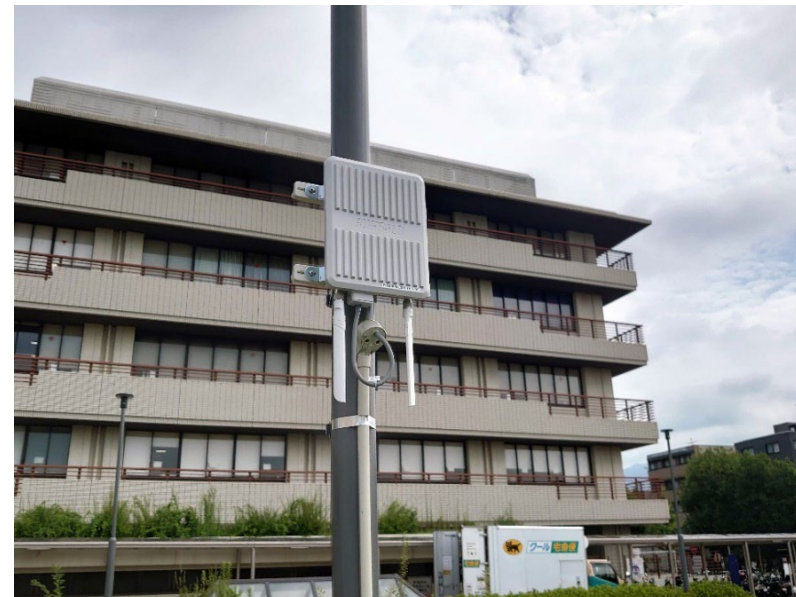
防塵・防水・耐環境性能 直射日光・屋外・寒冷地 設置対応 無線LANアクセスポイント
