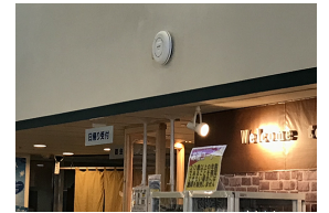
「道の駅(四季の館)」に設置された多回数同時接続可能な「WAPM-2133TR」。
